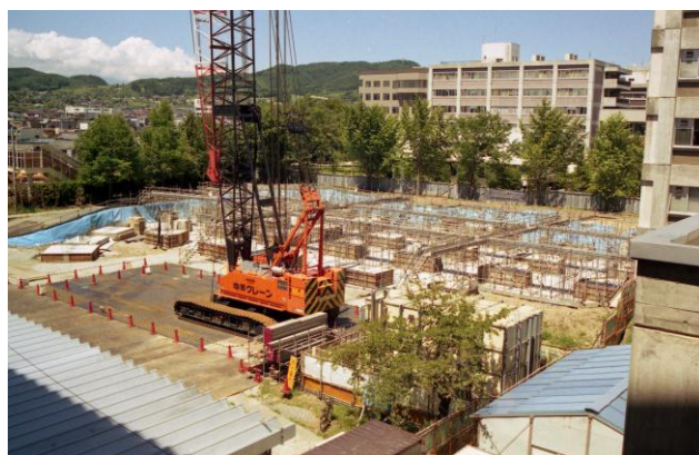
理学部 C 棟 新築中
