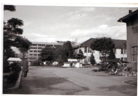
建設中の理学部
